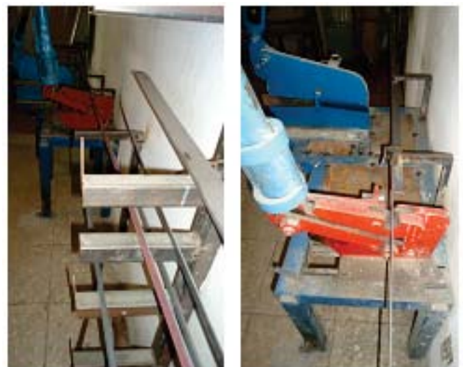
Fig. 1. Corte de perfiles rectos con sistema de cizalla.
