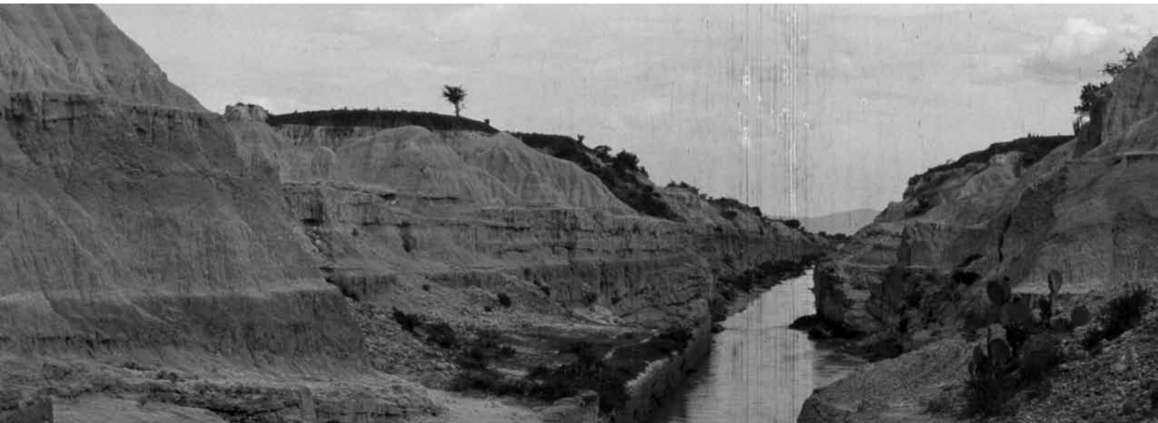
Fig. 2. El canal de Nochistongo, construido para encauzar el agua fuera del Valle de México.
