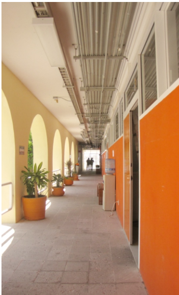
Instalaciones del CGEO.
