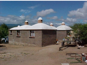
Construcción de la Vivienda Semilla.
