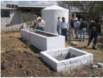
Cisterna de ferrocemento.
